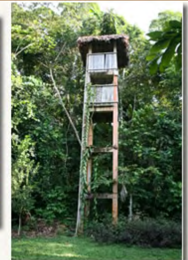
Sistema de Agua
