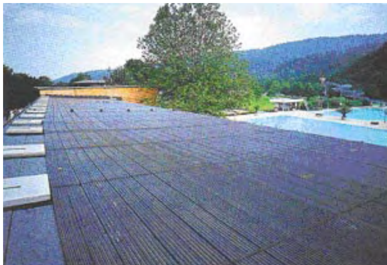
Fotografía 5: La fotografía muestra un sistema calefacción solar de una piscina para calentar el agua. Fuente de información: Municipio de Friburgo (Alemania).
