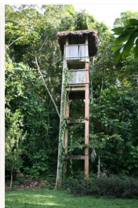
Sistema de Agua
